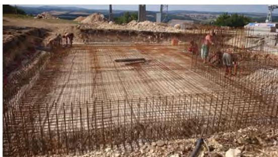
Fundamentplatte Bergstation
