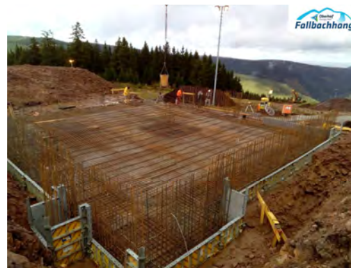
Fundamentplatte Bergstation
