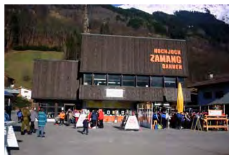
Talstation mit der alten Fassade
