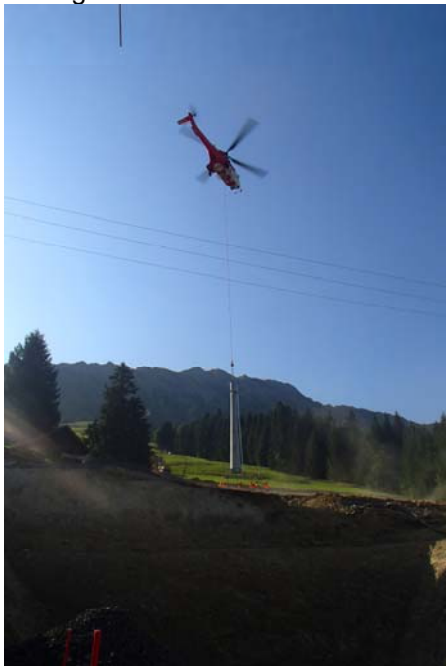
Stützenmontage mit Hubschrauber
