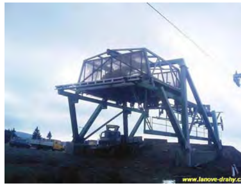
Bergstation mit dem Brückenantrieb
