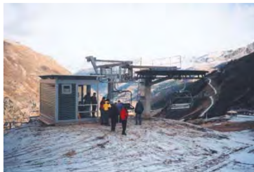
Bergstation fixe Umlenkstation
