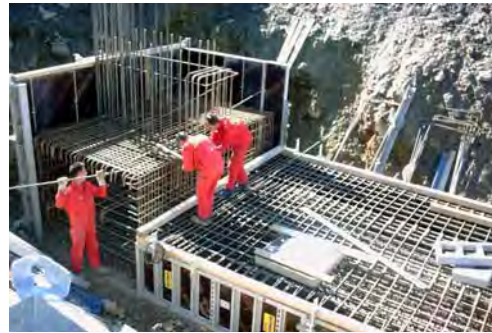
Fundamentsohle Bergstation in 10m Tiefe
