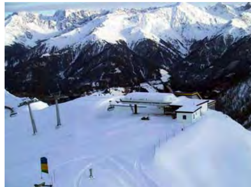
Bergstation mit Kellerbahnhof
