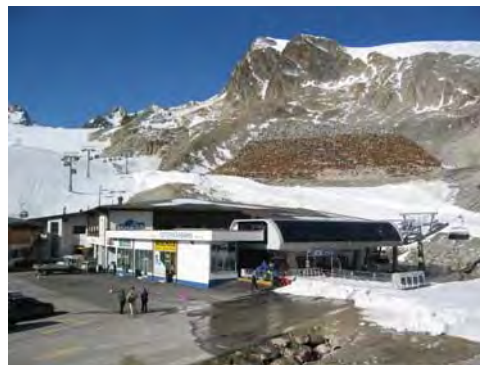
Talstation bei der Abnahme
