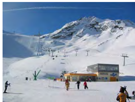
Talstation von dem Parkplatz
