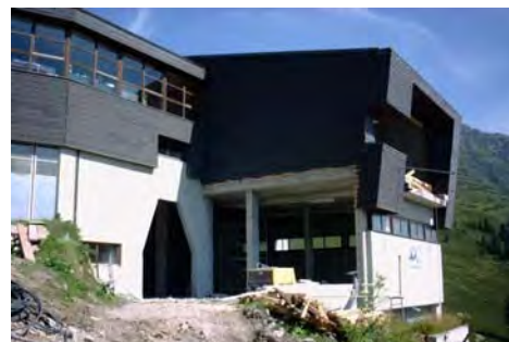
Bergstation Erweiterung des Bahnhofes während des Baus
