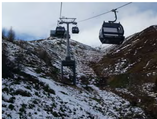
Stütze mit Lawinenschutzfundament
