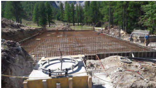
Fundamentplatte Bergstation
