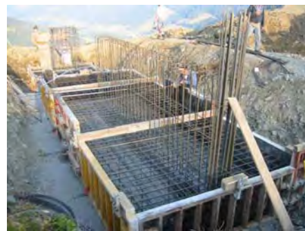
Bergstation Sohle Abspannfundament
