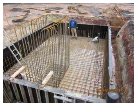
Abspannfundament
