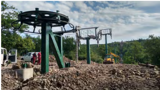
Talstation währen der Montage
