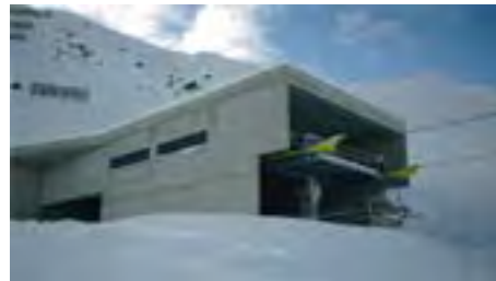
Bergstation mit Lawineneinhausung
