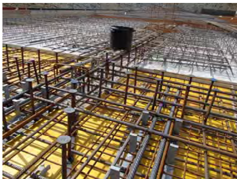
Bahnhofsdecke mit Schubdübel
