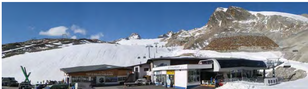
Nach dem Umbau
