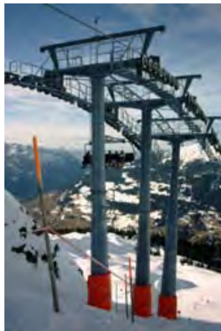
3-fach Stütze vor der Bergstation
