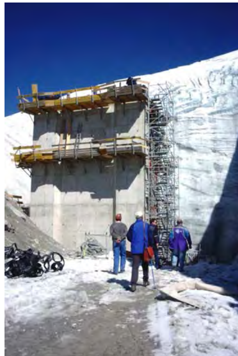
Das Fundament 25m im Eis
