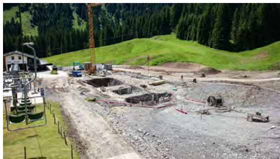
Fundamentaushübe in der Talstation
