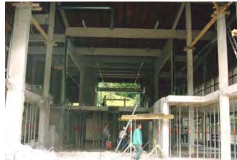
Talstation während der Bauarbeiten
