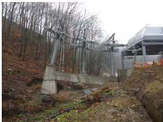
Die Talstation mit den Ausfahrtstützen
