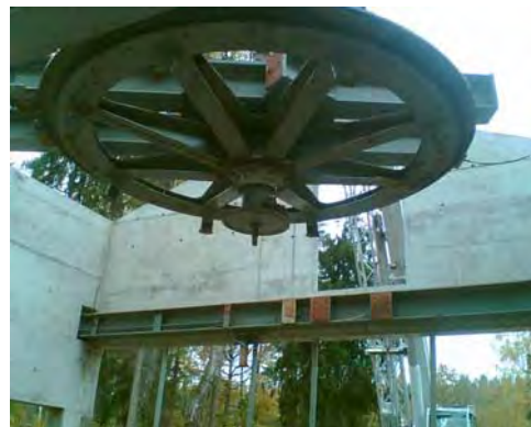
Talstation – Montage Antriebsrahmen
