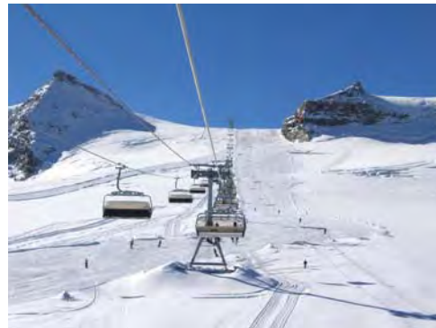
Gletscherstützen der Furggsattelbahn
