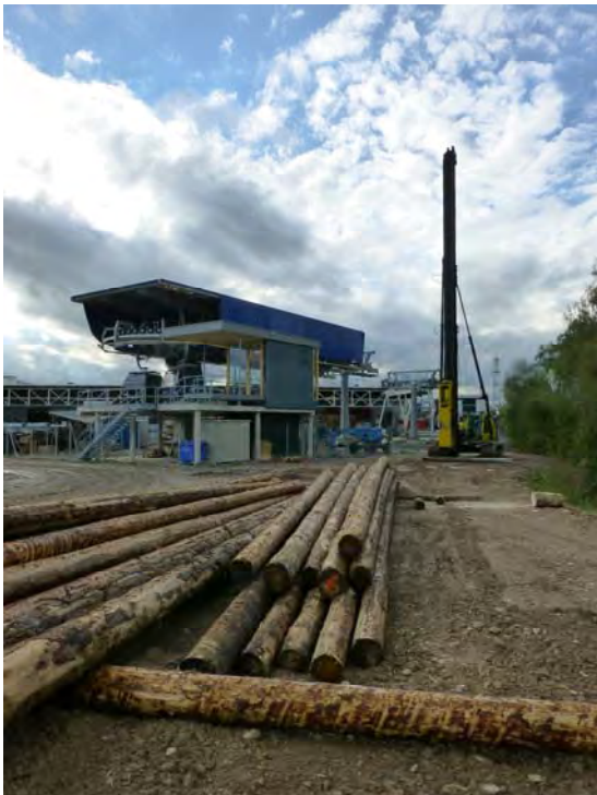
Pfählmachine mit den Holzpfählen
