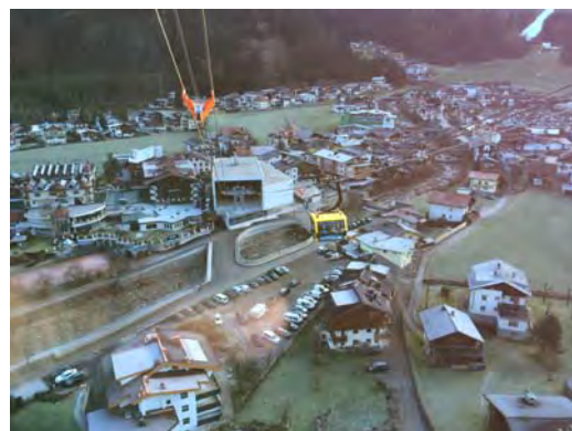
Talstation mit der neue Brücke
