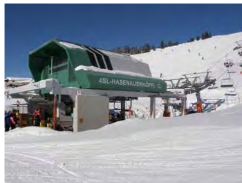
Talstation mit dem Brückenantrieb
