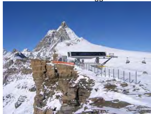
Bergstation der Furggsattelbahn
