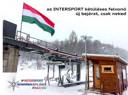
Talstation mit der Seilspannung
