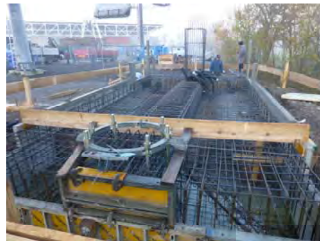
Fundament Antriebsstation
