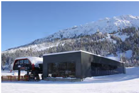
Talstation mit Sesselbahnhof
