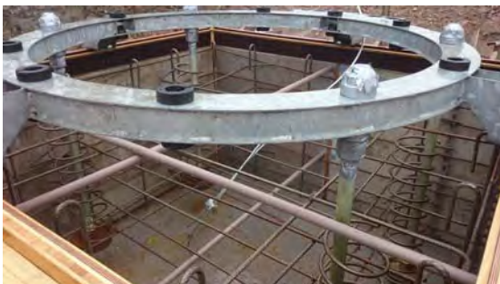
Stützenfundament
