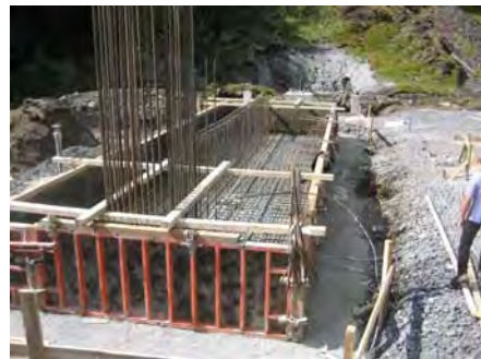
Talstation Abspannfundament
