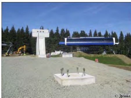
Abspannssockel Bergstation
