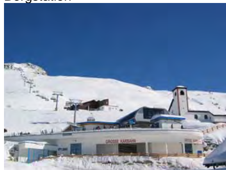
Talstation mit der Strecke
