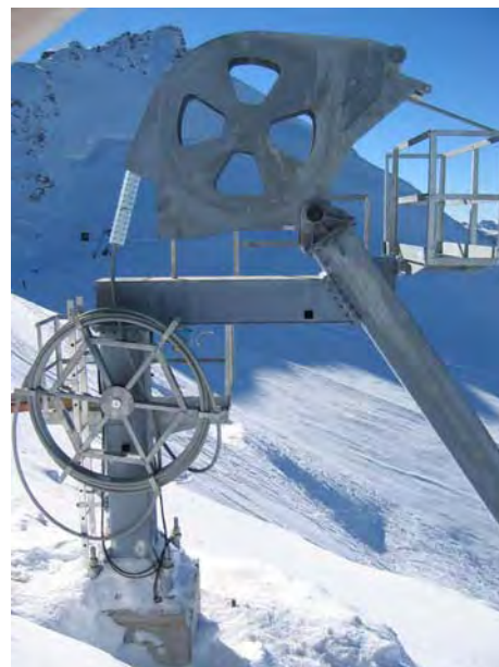
Abspannbock Bergstation
