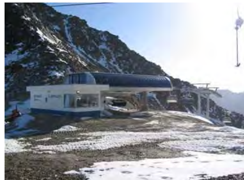
Bergstation mit Dienstobjekt SL Seiterjöchel
