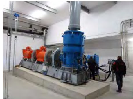
Unterflurantrieb
