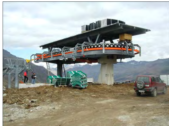
Traggerüstmontage Bergstation
