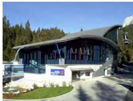
Talstation nach der Sanierung
