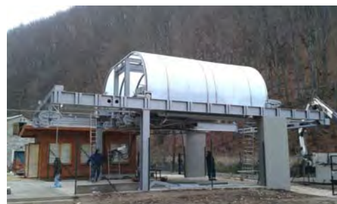
Die Antriebsbrücke mit neuer Verkleidung
